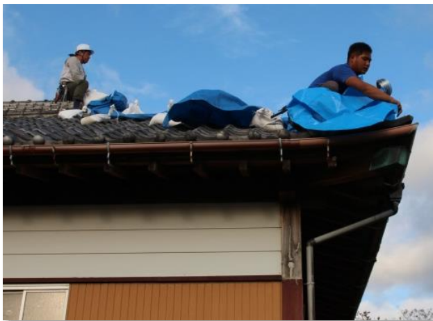
▲屋根へのブルーシート養生
